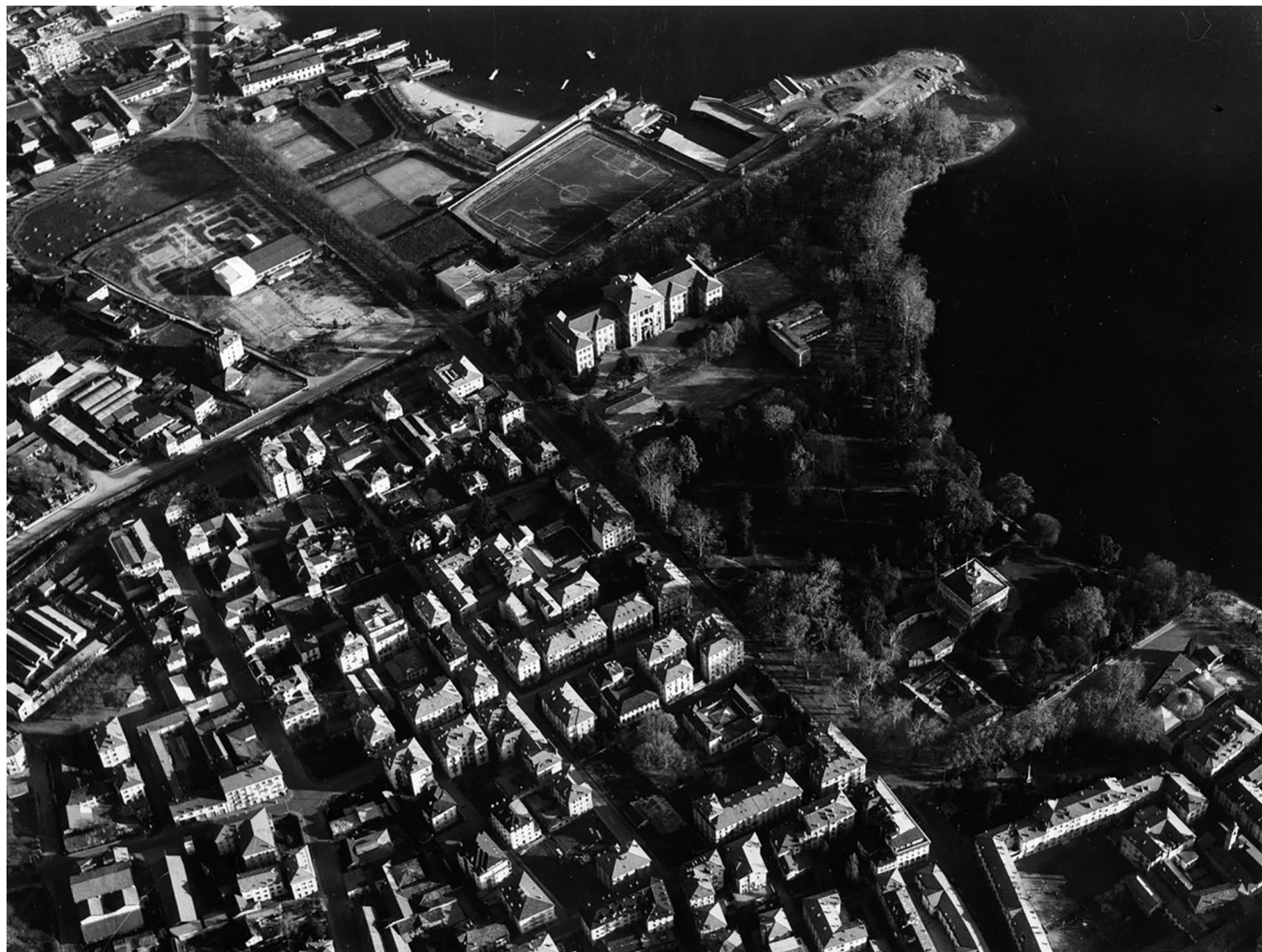
Veduta aerea di Lugano dal Parco Ciani a Via Serafino Balestra / Vue aérienne de Lugano du Parco Ciani à la Via Serafino Balestra, 1949 © Vincenzo Vicari / Archivio storico della Città di Lugano
